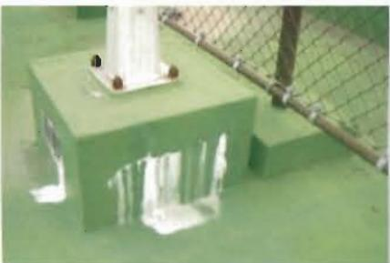
防水の裏側に雨水侵入・塗膜防水破断
