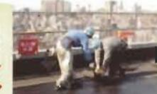
アスファルト防水には、防水層の上をコンクリートで保護する押えコンクリート仕上げと、砂の付いたシートで仕上げる畳出仕上げの2タイプがあります。
