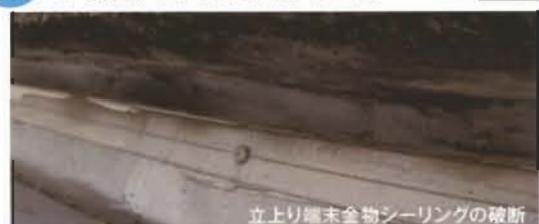
立上り端末金物シーリングの破断
